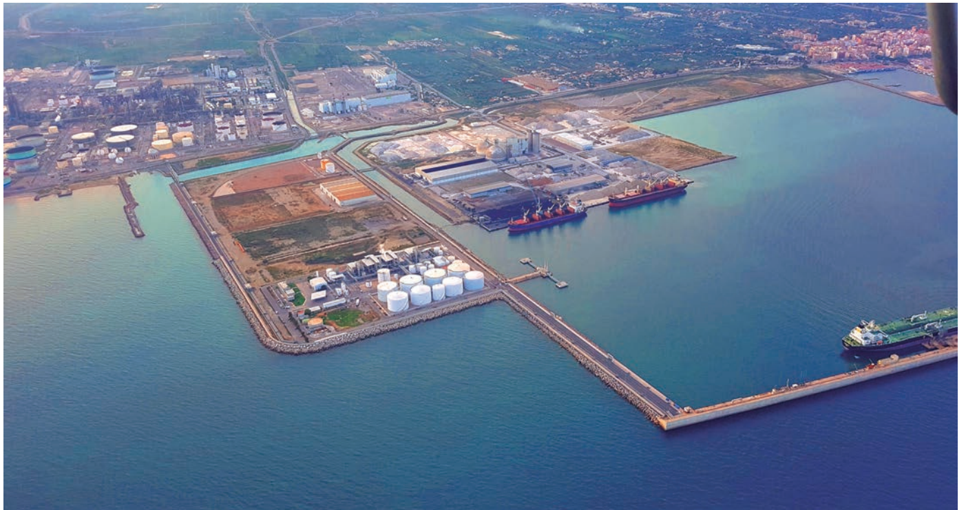
La Dársena Sur del Puerto de Castellón contará con dos atraques para graneles líquidos durante el próximo año.
